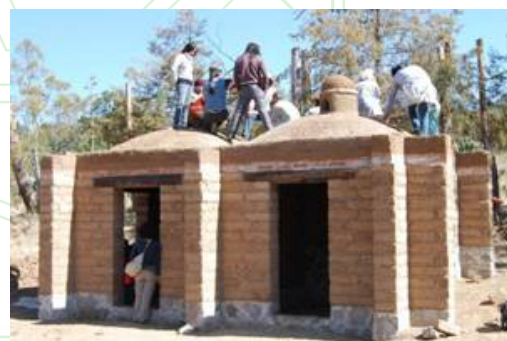
Fig. 8. Edificio con muros y bóvedas de adobe realizado por Alejandra Caballero y Ramón Aguirre en el Proyecto San Isidro, Tlaxco, Tlaxcala. (Foto L. Guerrero)
