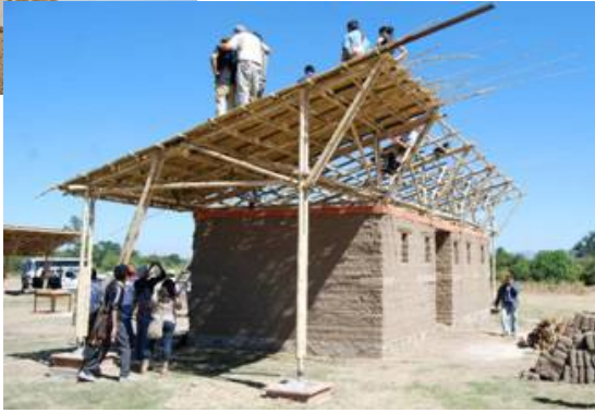
Fig. 10. Centro deportivo comunitario realizado mediante autoconstrucción asistida con adobe, bambú y carrizo en San Pedro, Oaxaca. Proyecto de João Caeiro y Juan José Santibáñez (Foto L. Guerrero)
