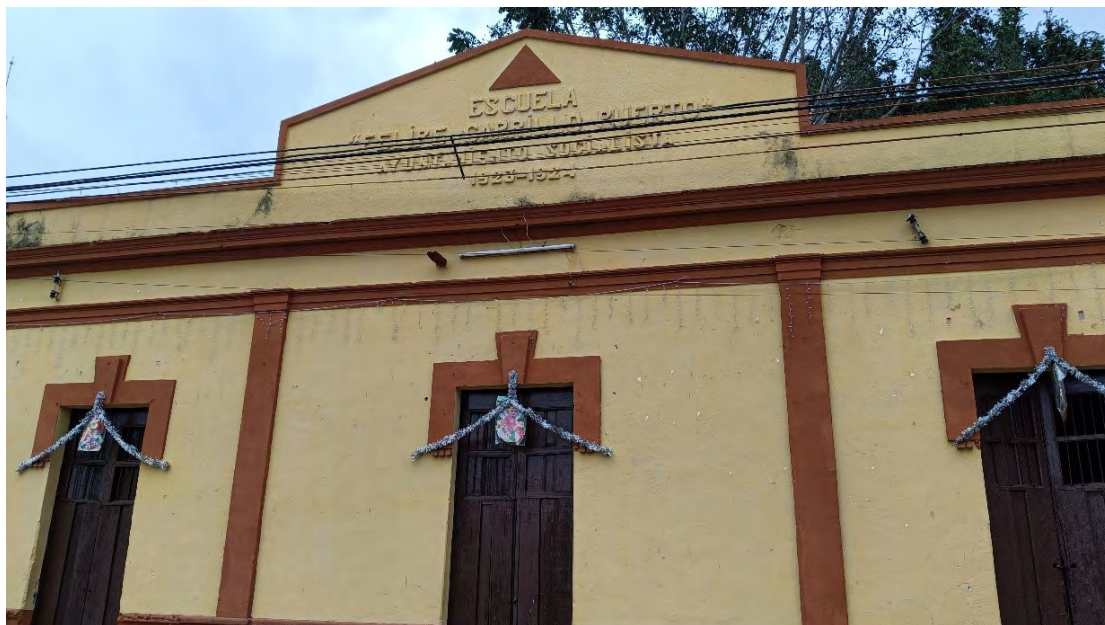
Figura 5. Sede de la comisaría de San José Tzal, anteriormente fue la Escuela Felipe Carrillo Puerto. Fuente: fotografía de los autores (2024).
