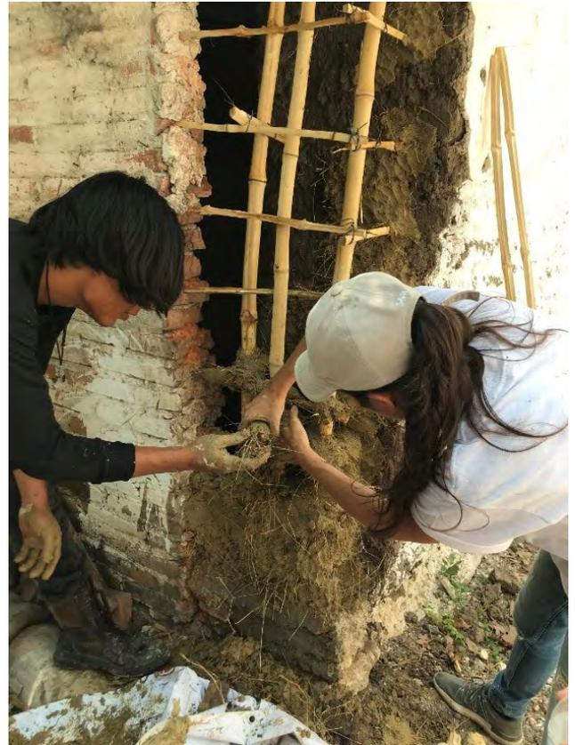
Figura 13. Conexión entre un muro de ladrillo y uno de adobe, realizada en una casa tradicional durante un taller en Tuxtla Gutiérrez, Chiapas. Foto: L. Guerrero.
