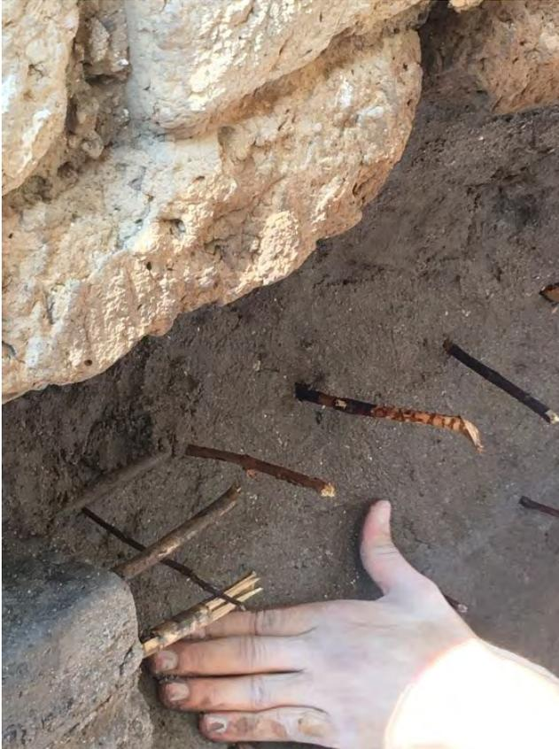
Figura 12. Aplicación de las esferas sobre las varas ancladas al contorno de un hueco derivado de la erosión de adobes, Lagos de Moreno, Jalisco. Foto: L. Guerrero.
