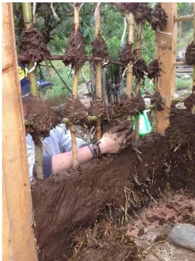
Figura 8. Estructura con entramado reticular para un sanitario seco realizado durante un taller infantil en Zautla, Puebla. Foto: L. Guerrero.
