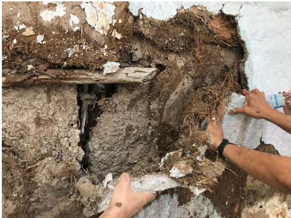
Figura 4. La gruesa capa de cemento con la que se recubrió esta casa tradicional de Tuxtla Gutiérrez, Chiapas, en los años setenta, provocó la acumulación de agua al interior del muro y la degradación de su entramado.
