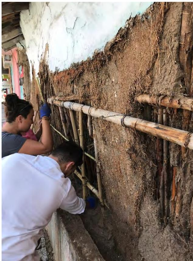
Figura 11. Colocación y atado de un emparrillado hecho de bambú. Tuxtla Gutiérrez, Chiapas. Foto: L. Guerrero.
