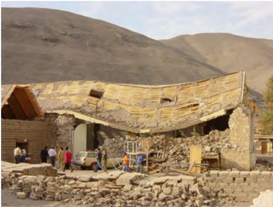
Figura 3. Daños provocados por la dala de concreto colocada sobre los muros de adobe del templo de San Lorenzo de Tarapacá, Chile, tras un terremoto en 2005. Foto: L. Guerrero.
