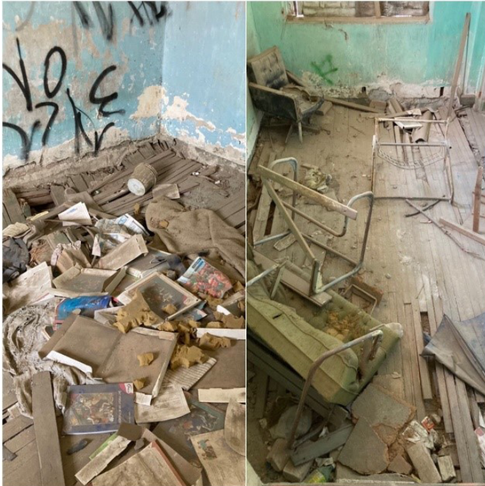
Figura 7: Interior de lo que fueron las oficinas de la mina. Elaboración propia, 2022.
