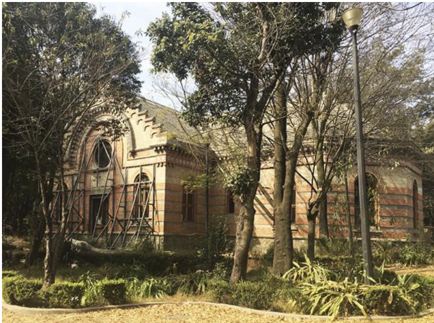
Fig. 11. Fachada principal de la biblioteca José Revueltas, 2020. El abandono y acceso libre aceleran su deterioro. Fuente: Colección de los autores.
