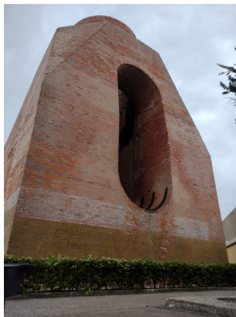
Figura 5. Monumento al Obrero Desconocido , basamento del Horno de la empresa metalúrgica de la Gran Fundición Central Mexicana. Fotografía de Alba Díaz Márquez, año 2021.
