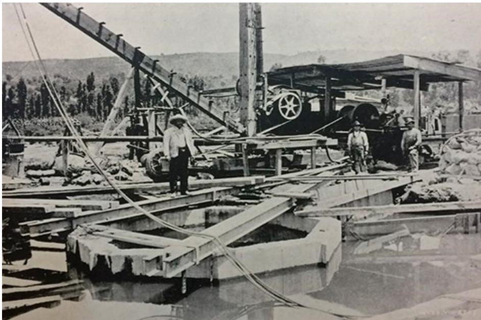
Fig. 9. El pozo de captación de Nativitas está en construcción, ca. 1905. El ambiente lacustre permitió usar al concreto debido al fraguado bajo el agua. Fuente: Manuel Marroquín y Rivera (1914).
