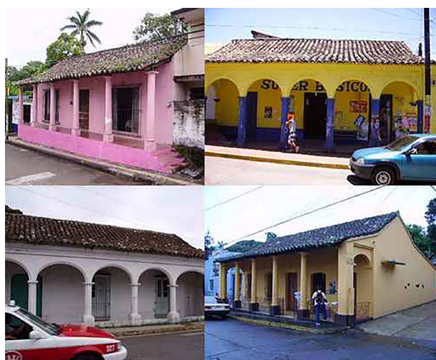
Figura 7. Imágenes de fachadas principales de la vivienda tradicional en San Andrés Tuxtla. Fuente: Propia.
