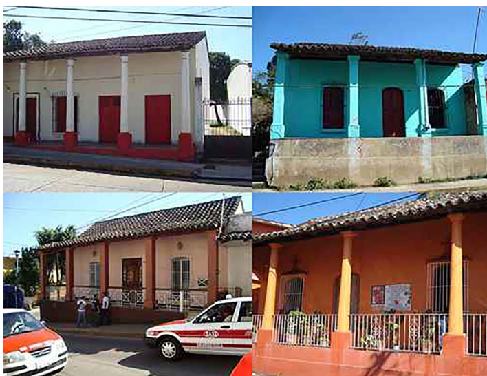
Figura 4. Fotografías de columnas en pórticos de San Andrés Tuxtla. Fuente: Propia.
