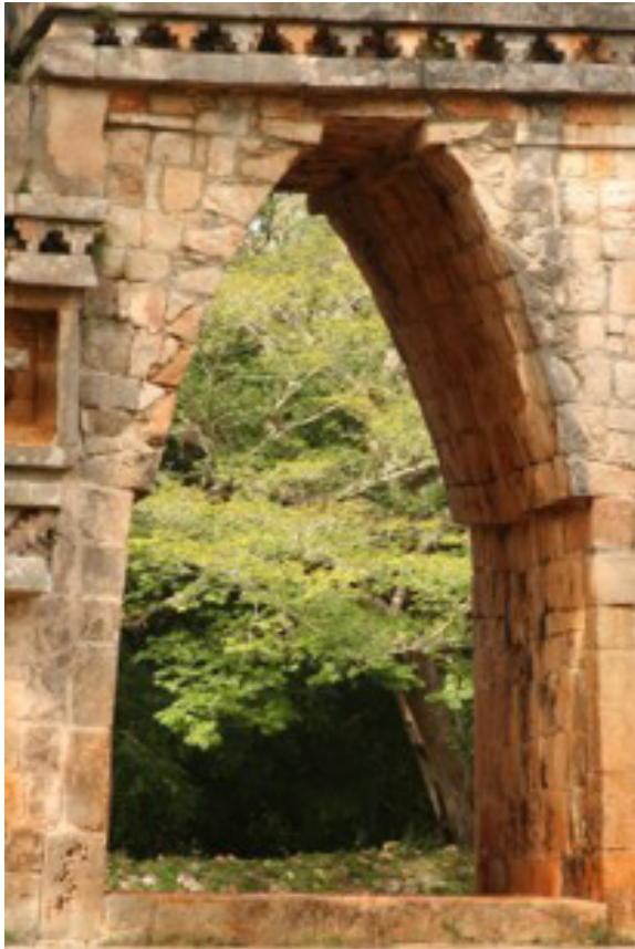
Imagen 4.: El Arco Monumental de Labná. “El arco magnifica el acceso, y constituye un filtro de privacidad entre un espacio público como es la plaza y el patio interior del conjunto, que tiene un carácter más privado. Para acceder se ha de subir a la plataforma del arco, para luego bajar a través de escaleras, enfatizando así el acto de entrar al recinto”. Gilabert: p. 59. Fotografía Juan Carlos Mansur Garda.
