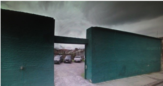
Figura 19. El muro de adobe de la fachada principal mide 4.72 m de altura, y presenta un guardapolvo de 0.58 m de alto, con un recubrimiento de ladrillos. Sus dimensiones son 0.26 x 0.15 x 0.05 m. El muro presenta un aplinado final de (cal-arena), y se encuentra pintado. Fuente: Jiménez (2006-2007).
