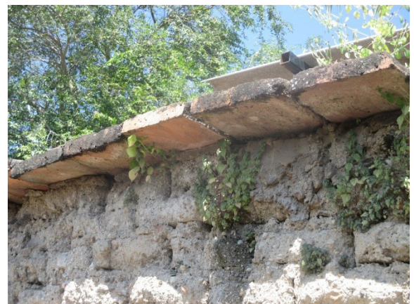
Figura 18. Ladrillo de barro rojo (0.25 x 0.15 x 0.07m), para cubrir la corona de los muros de tabique rojo. Fuente Jiménez (2006-2007).
