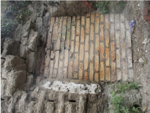
Figuras 22, 23, 24, 25 y 26) Casa del lado Norte del predio de estudio. En su muro Sur muestra un acceso cancelado con tabiques, y presenta un dintel de madera del árbol llamado mapa o guanacastle; sus dimensiones son 1.45 de largo x 0.11 de espesor (el ancho no se pudo medir) Fuente: Jiménez (2006-2007).
