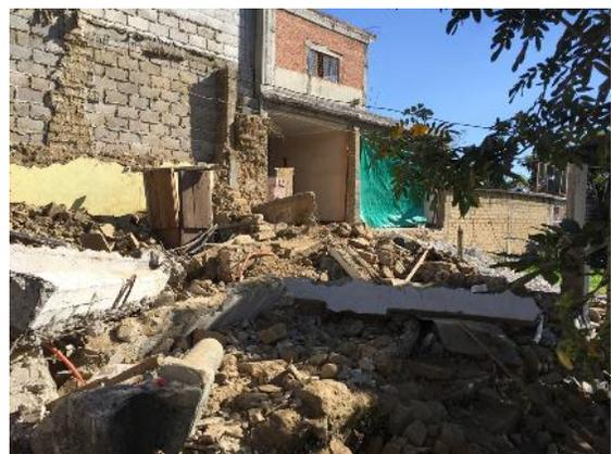
Figura 15. Refuerzos de concreto en muros de adobe colapsados. Hueyapan, Morelos.
