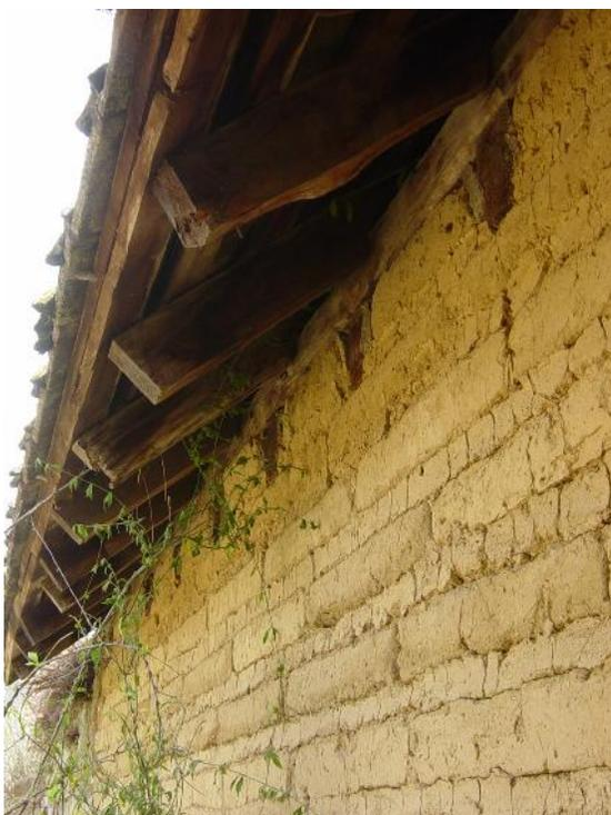
Figuras 12 y 13. Las vigas y tirantes que ligan los muros, Ayapango, Estado de México.
