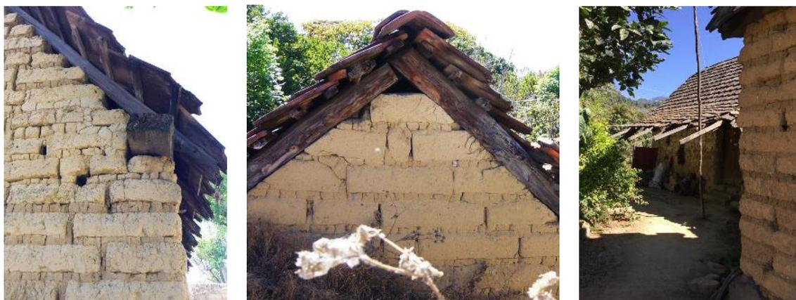
Figuras 7, 8 y 9. Los arriostres y pares interactuaban por fricción. Alpanocan, Puebla.
