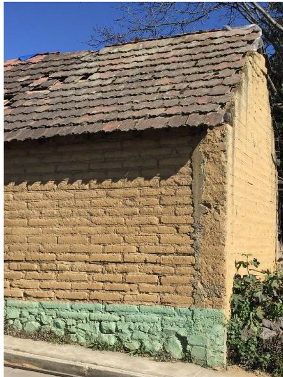
Figuras 5 y 6. La masividad de los muros los hace muy estables. Hueyapan, Morelos.
