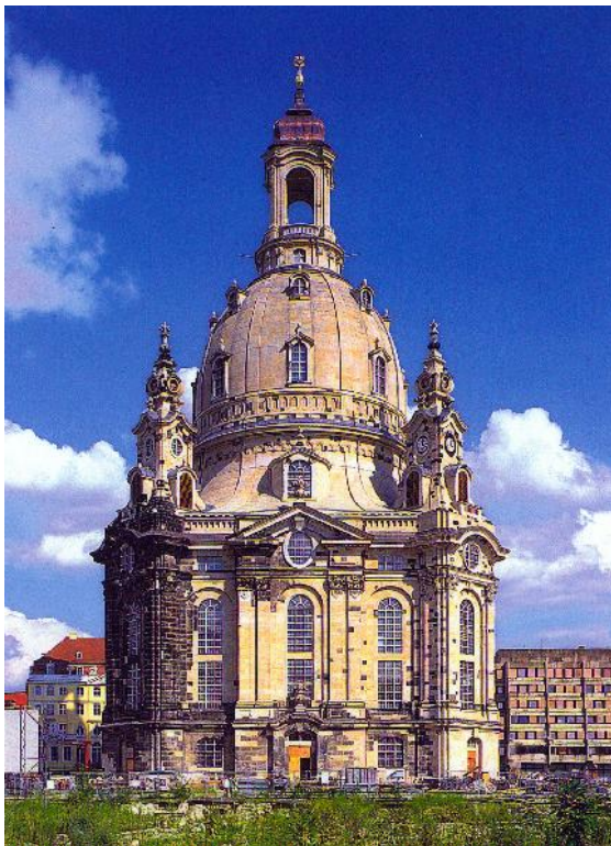
4 - Reconstrucción de la Frauenkirche de Dresde, estado actual.
