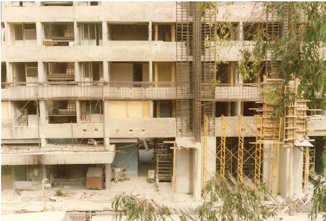
Figura 3. Trabajos de fortificación del edificio tipo “C” en Tlatelolco, en 1987. Fuente: Antonio Fonseca. (abril 2012) ¿Cómo se fortificaron los edificios similares al edificio Nuevo León después del terremoto del 1985 en Tlatelolco? octubre 10 2018, de Vivir en Tlatelolco Sitio web: <http://vivirtlatelolco.blogspot.com/2012/04/como-se-fortificaron-los-edificios.html>, fotografía de David Velasco Pimentel.
