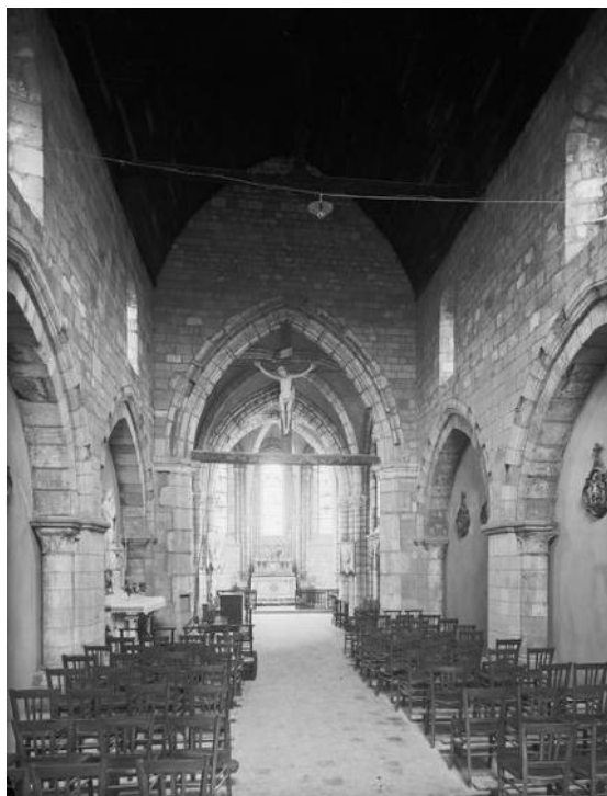
Figura 6 b - Iglesia de la Asunción de Ambrières. Interior hacia la cabecera. Estado tras la reconstrucción y restauración de la iglesia. Se ha depurado el mobiliario litúrgico y se perciben desde el interior las arquerías que separaban la nave de las colaterales desaparecidas. Fotografía de René Gandilhon. Base Merimée. Ministère de la Culture France - Médiathèque de l'architecture et du patrimoine. Ref. PA00078567.
