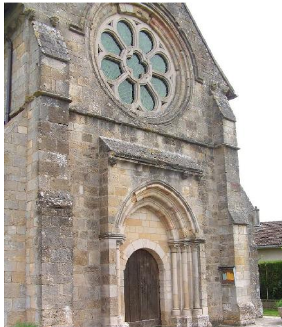
Figura 4b - Iglesia de la Asunción de Ambrières. Fachada occidental de la iglesia antes de su desmonte. Fotografía de René Gandilhon. Base Merimée. Ministère de la Culture France - Médiathèque de l'architecture et du patrimoine. Ref. PA00078567
