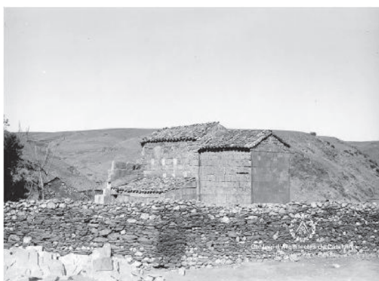
Figura 12 - Iglesia de san Pedro de la Nave. Estado del monumento cuando se había efectuado la primera parte del desmontaje y quedaba en pie la cabecera. Septiembre de 1930. Colegio de Arquitectos de Cataluña. Demarcación de Lérida. Fondo Alejandro Ferrant, sig. 496-1196.
