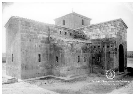
Figura 15 - Iglesia de san Pedro de la Nave. Exterior después de su reconstrucción y restauración. Puede observarse la zona recrecida sobre el pórtico y el cimborrio rehecho mediante ladrillo. Colegio de Arquitectos de Cataluña. Demarcación de Lérida. Fondo Alejandro Ferrant, sig.496-1164.
