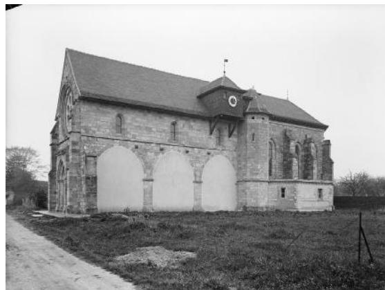
Figura 5 b - Iglesia de la Asunción de Ambrières. Fachada Sur de la iglesia después de su reconstrucción y restauración. Se observa la desaparición de las huellas de la cubierta de la nave colateral y la nueva sacristía, que sustituyó a la original y la reconstrucción del cuerpo del reloj. Fotografía de René Gandilhon. Base Merimée. Ministère de la Culture France - Médiathèque de l'architecture et du patrimoine. Ref. PA00078567.
