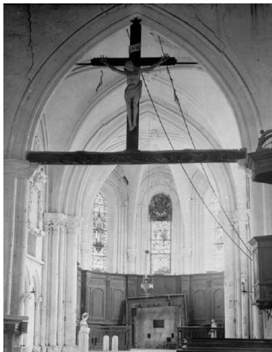
Figura 6 a - Iglesia de la Asunción de Ambrières. Interior hacia la cabecera. Estado anterior al desmontaje de la iglesia. Fotografía de René Gandilhon. Base Merimée. Ministère de la Culture France - Médiathèque de l'architecture et du patrimoine. Ref. PA00078.
