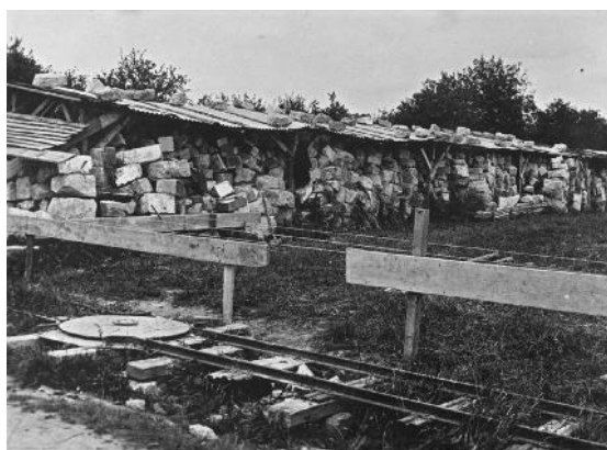
Figura 3 - Iglesia de la Asunción de Ambrières. Los sillares del edificio almacenados bajo unas cubiertas. No presentan números para identificar su situación. Fotografía de René Gandilhon. Base Merimée. Ministère de la Culture France - Médiathèque de l'architecture et du patrimoine. Ref. PA00078567.
