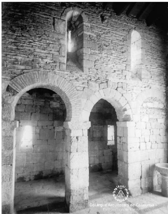
Figura 13 - Iglesia de san Pedro de la Nave. Estado de la arquería meridional de la nave central después de su reconstrucción y restauración. Las desigualdades de los arcos evidencian las estratificaciones históricas, que se mantuvieron. El arco inmediato a la fachada, que observamos a la derecha, permaneció macizado para garantizar la estabilidad del monumento. Colegio de Arquitectos de Cataluña. Demarcación de Lérida. Fondo Alejandro Ferrant, sig. 495-1190.
