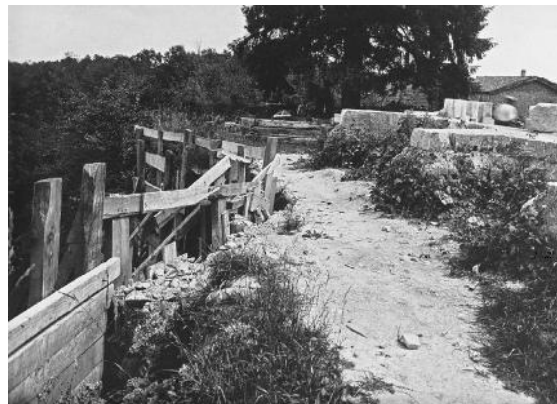
Figura 1 - Iglesia de la Asunción de Ambrières. El edificio ha sido desmontado hasta sus hiladas inferiores y puede observarse que estaba situado junto a una ladera prácticamente derrumbada. Fotografía de René Gandilhon. Base Merimée. Ministère de la Culture France - Médiathèque de l'architecture et du patrimoine. Ref. PA00078567.
