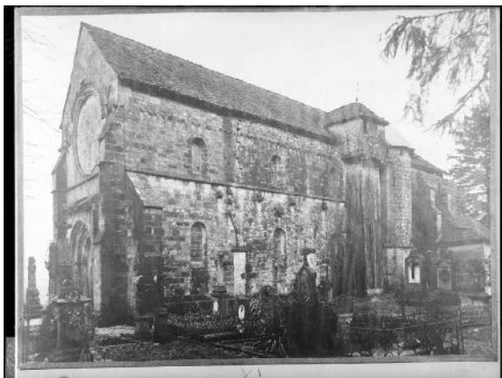
Figura 5a - Iglesia de la Asunción de Ambrières. Fachada Sur de la iglesia antes de su desmonte. Se observan los arcos de las desaparecidas naves colaterales. Están cegados y en su antiguo vano se han abierto ventanales. Fotografía de René Gandilhon. Base Merimée. Ministère de la Culture France - Médiathèque de l'architecture et du patrimoine. Ref. PA00078567.
