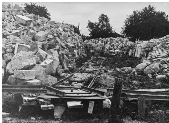
Figura 2 - Iglesia de la Asunción de Ambrières. Los sillares del edificio desmontado junto a la vía férrea construida para transportarlos. Fotografía de René Gandilhon. Base Merimée. Ministère de la Culture France - Médiathèque de l'architecture et du patrimoine. Ref. PA00078567.
