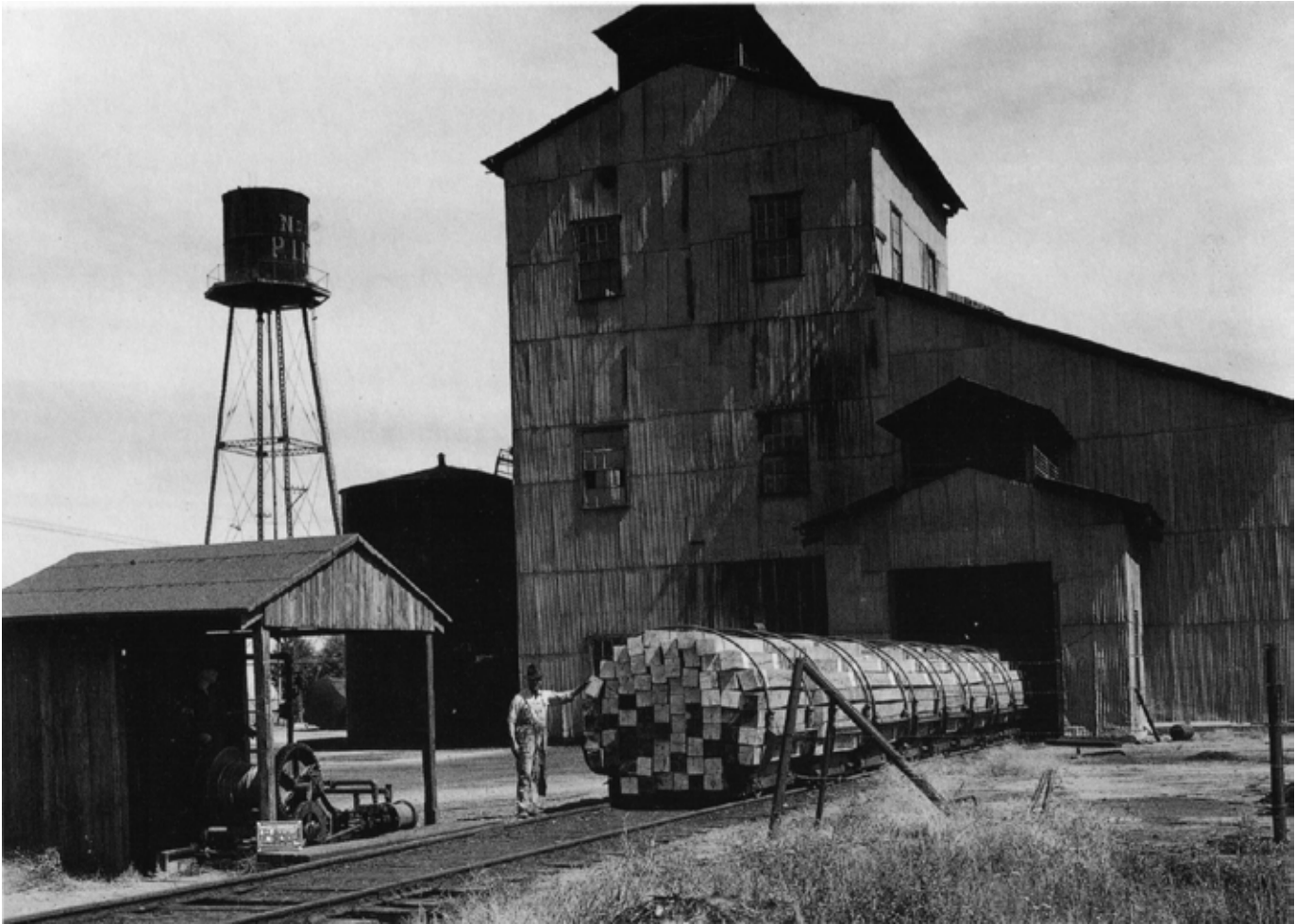
Figura 5. Planta creosotadora de durmientes. Imagen: Fototeca del Museo Nacional de los Ferrocarriles Mexicanos
