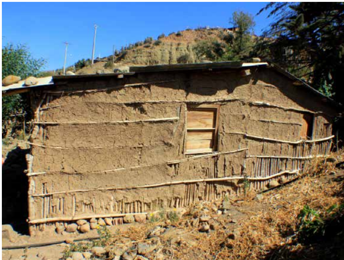
Figura 5. Vivienda de quincha de puyas. Fotografía realizada por autora, 2013, Tunga Sur.
