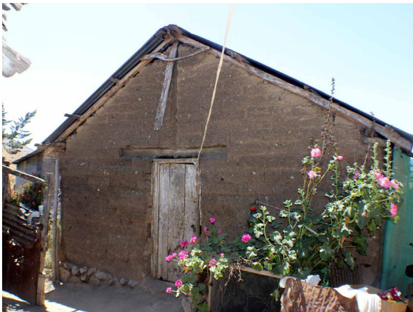
Figura 9. Vivienda de adobe en las cercanías de Micha sur. Fotografía realizada por autora, 2013, Mincha sur.
