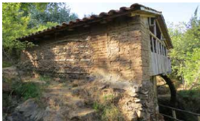
Figura 9. Detalle de un muro, que acusa la presencia de técnicas constructivas tradicionales en el campo chileno. Molino de Rodeillo, Pichilemu. Registro fotográfico: Bravo, J., 2015, Santiago de Chile.
