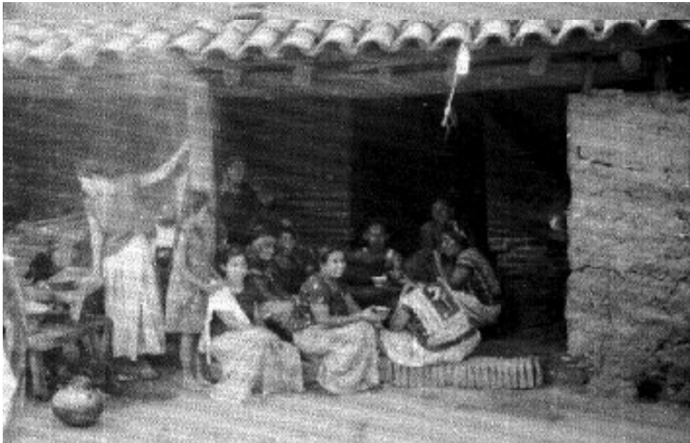
Figura 12. Vivienda de muros de bajareque con cubierta de teja en fotografía de 1945. Título original: Personas de la población de Juchitán, debajo de un tejado de una casa. Fuente: Colección Archivo Casasola - Fototeca Nacional.
