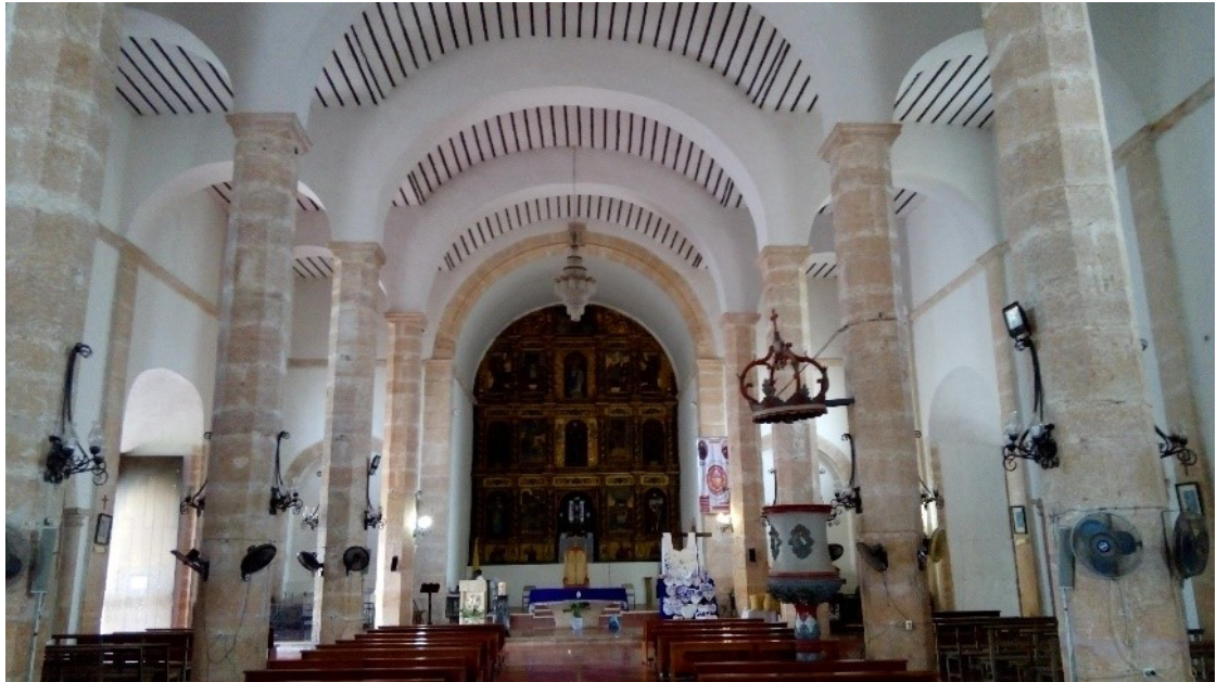
Figura 5. Interior de la iglesia de Oxkutzcab de tres naves cubiertas con bóvedas de rollizos Fuente: autoría propia.
