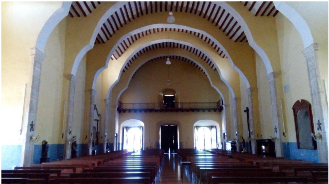
Figura 6. Interior de la nave de la iglesia de Hunucmá en donde se aprecia el sistema constructivo de la bóveda de rollizos. Fuente: autoría propia.
