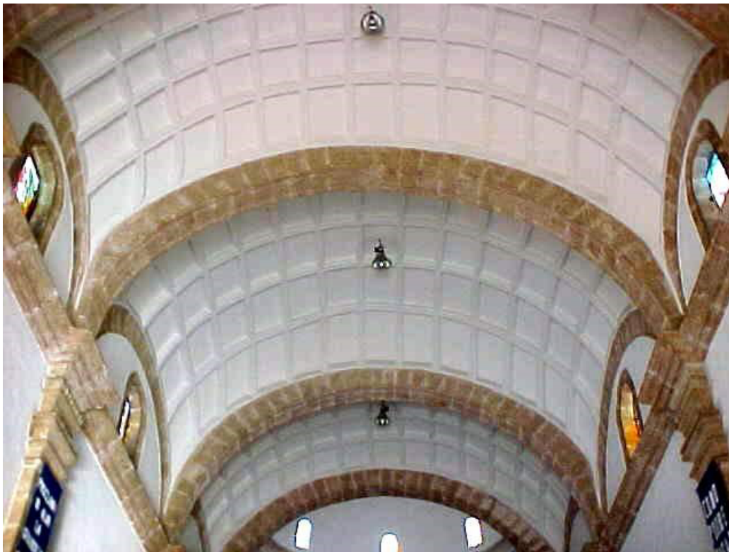
Figura 9. Interior de la nave de la iglesia de Nuestra Señora de Guadalupe en el barrio de San Cristóbal n Mérida, Yucatán. Se observan las bóvedas baídas con casetones sostenidas por arcos fajones de cantería terminadas en 1796. Fuente: autoría propia.
