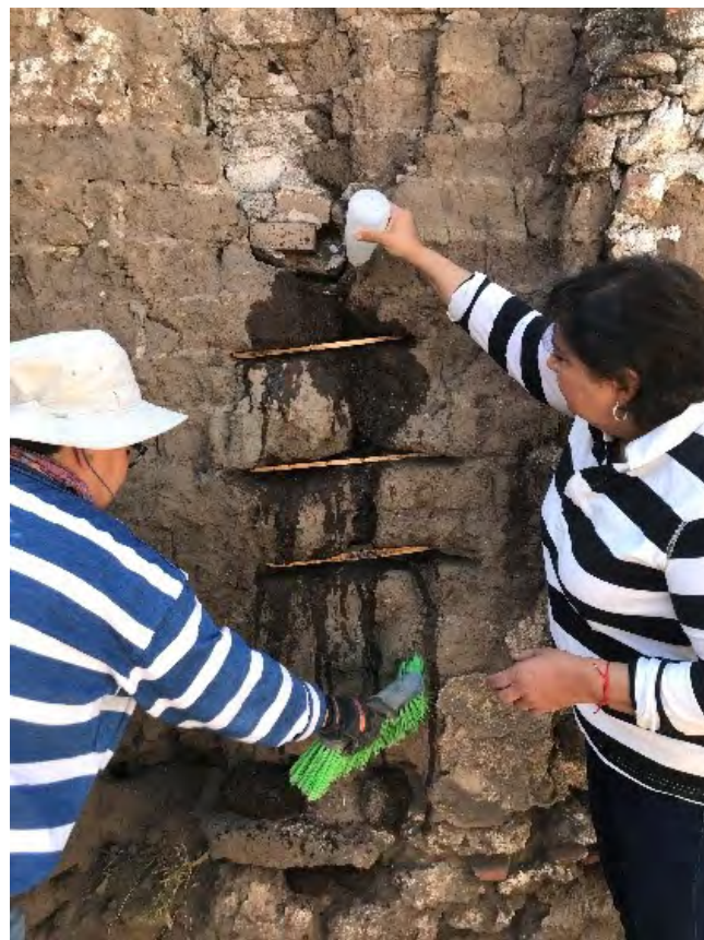
Figura 9. Humectación periódica durante una intervención realizada en un edificio patrimonial en Valle de Santiago, Guanajuato. Foto: L. Guerrero.
