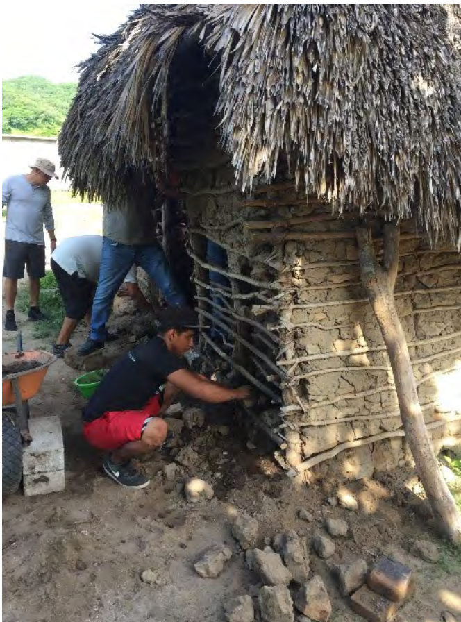
Figura 15. Intervención de una casa tradicional de bajareque en Huamelula, Oaxaca. Foto: L. Guerrero.
