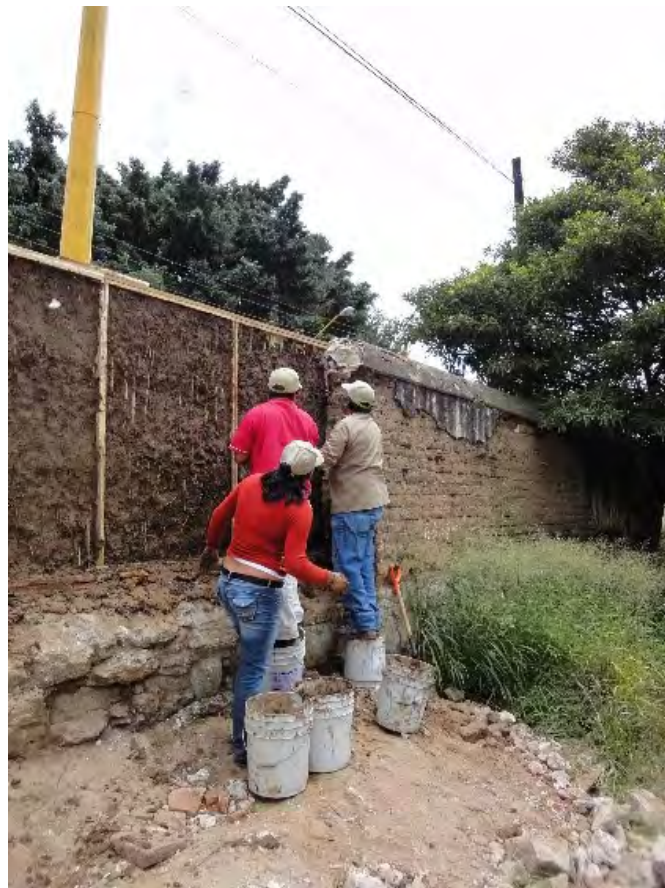
Figura 14. Integración de un tramo de muro entramado en un hueco de la barda perimetral de adobe de la antigua estación del ferrocarril de Oaxaca. Foto: L. Guerrero.
