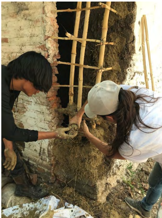
Figura 13. Conexión entre un muro de ladrillo y uno de adobe, realizada en una casa tradicional durante un taller en Tuxtla Gutiérrez, Chiapas. Foto: L. Guerrero.
