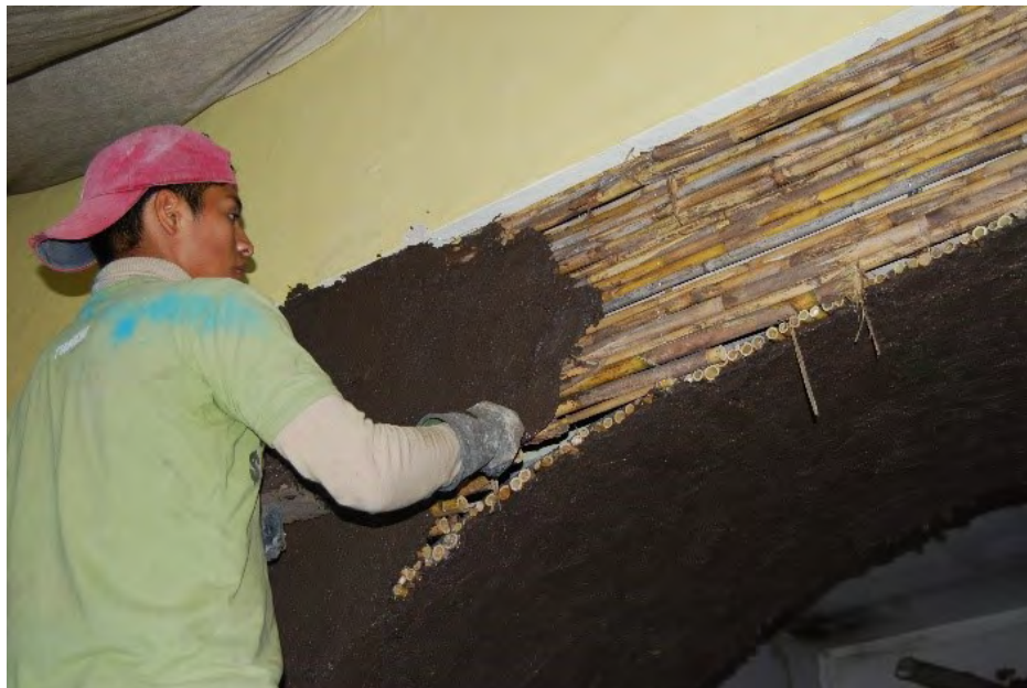
Figura 2. Integración de componentes entramados durante la restauración de una casa tradicional de adobe en Cuenca, Ecuador. Foto: L. Guerrero.
