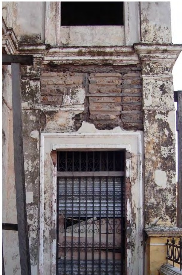
Figura 5. El uso de madera aserrada permitió el desarrollo de estructuras entramadas conocidas regionalmente como “taquezal”. Restauración de un edificio patrimonial en Granada, Nicaragua. Foto: L. Guerrero.
