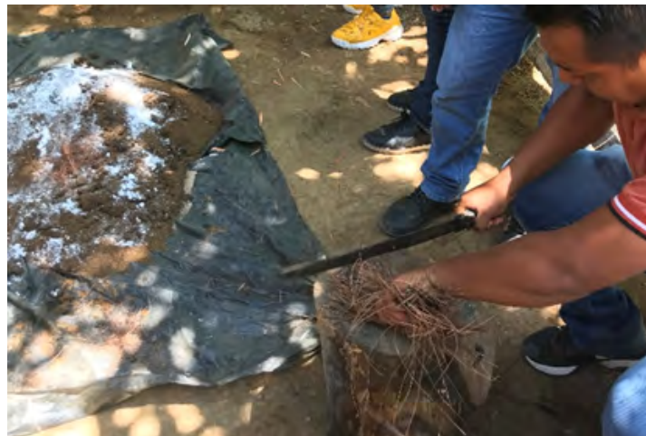
Figura 10. Estabilización de tierra con 5% de cal y fibras picadas, durante un taller comunitario en Mazatlán Villa de Flores, Oaxaca. Foto: L. Guerrero.
