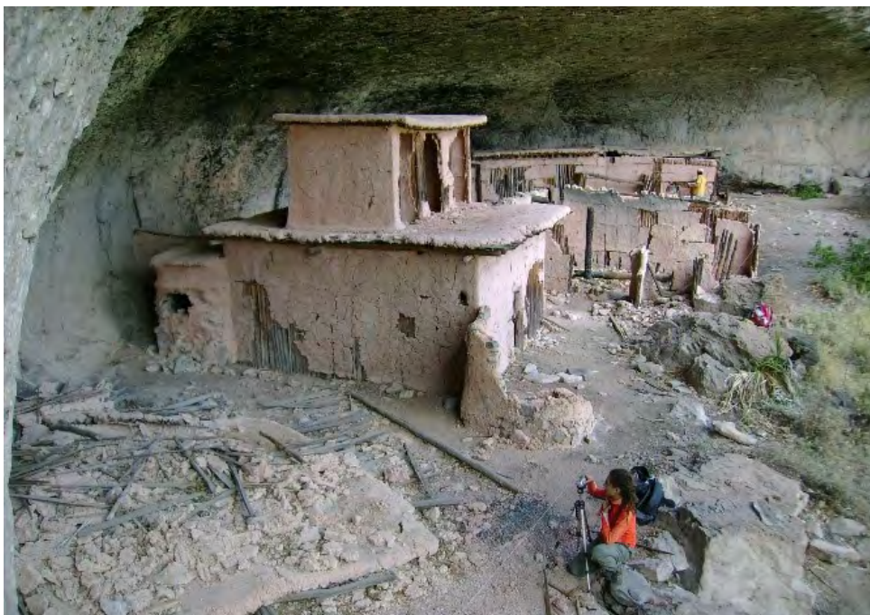
Figura 1. Conjunto habitacional de tierra entramada en la Cueva del Maguey, Durango. Foto: L. Guerrero.
