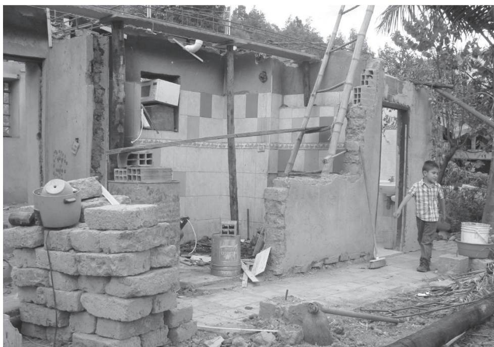
Figura 10. Proceso de construcción del primer nivel, vivienda Rodríguez Vargas. Fuente: fotografía tomada por la autora en el año 2015.
