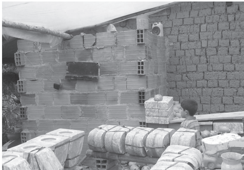
Figura 7. Volumen adosado de bloque cocido que contiene el baño y la cocina, vivienda Rodríguez Vargas. Fuente: fotografía tomada por la autora en el año 2012.
