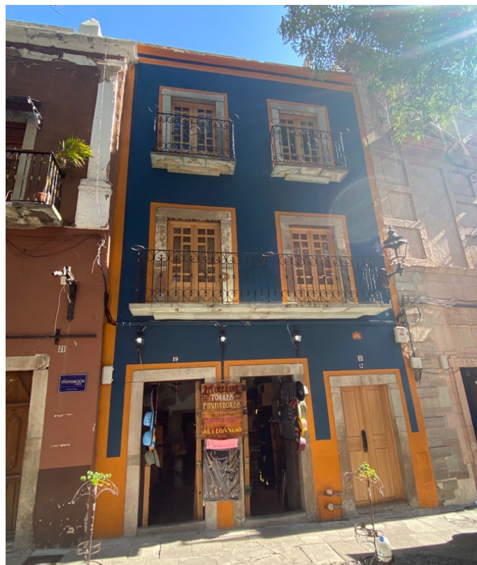
Figura 1. Edificio patrimonial catalogado actualmente con uso turístico en la plaza San Fernando de Guanajuato. Tienda de souvenirs en planta baja, y viviendas en Airbnb en niveles superiores. Fuente: Autor (2023).
