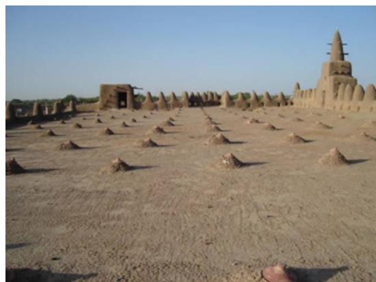
Fig. 2. La azotea de la Gran Mezquita de Djenné en Mali, el edificio de adobe más grande del mundo, posee un original sistema de control de temperatura interior basado en perforaciones que son tapadas y destapadas manualmente al amanecer y al anochecer. (Foto L. Guerrero)
