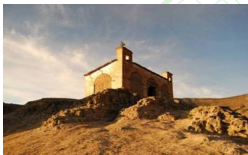
Fig. 6. La Capilla del Calvario en Mitla, Oaxaca, se erigió sobre los restos de un gran basamento ceremonial cuyo núcleo hecho de adobe ha quedado expuesto a la intemperie tras el saqueo que desde hace siglos se hizo de las piedras que lo recubrían.
