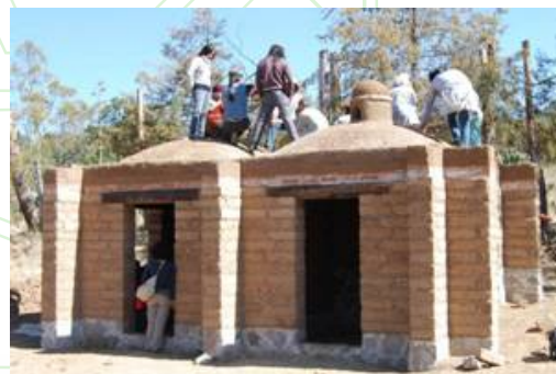
Fig. 8. Edificio con muros y bóvedas de adobe realizado por Alejandra Caballero y Ramón Aguirre en el Proyecto San Isidro, Tlaxco, Tlaxcala. (Foto L. Guerrero)
