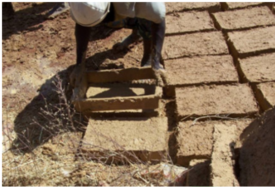
Fig. 4. En la ciudad de Djenné en Mali los procesos de elaboración de adobes prácticamente no han cambiado después de milenios. (Foto L. Guerrero)
