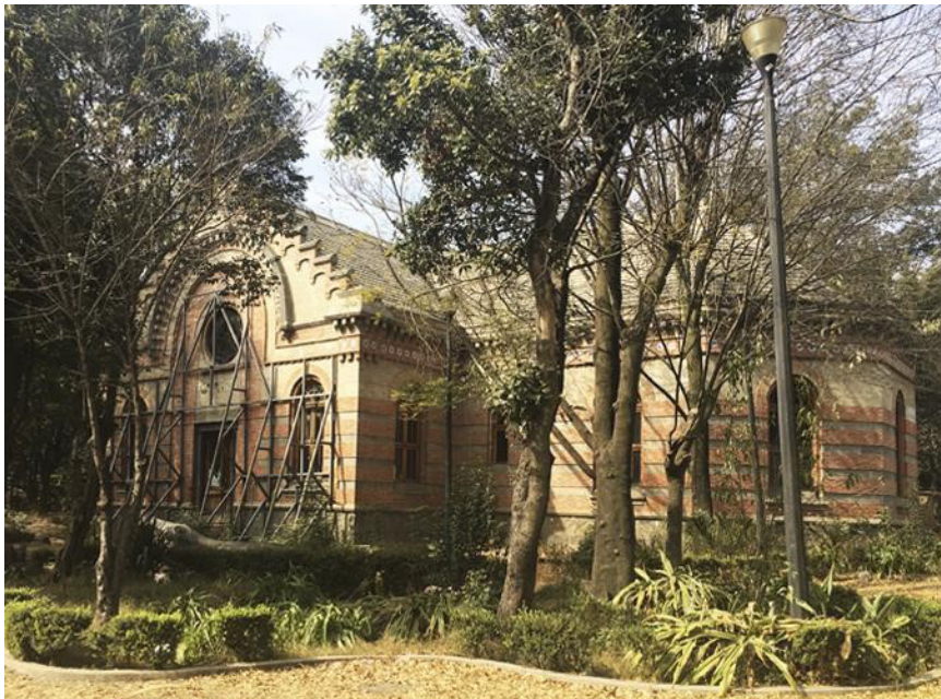
Fig. 11. Fachada principal de la biblioteca José Revueltas, 2020. El abandono y acceso libre aceleran su deterioro. Fuente: Colección de los autores.
