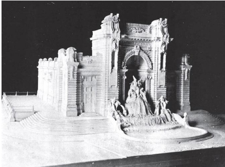
Fig. 1. Casa de bombas de la Condesa. Maqueta del edificio, ca. 1908. Proyecto que reúne las dos concepciones sobre la arquitectura: la tradicional y la técnica. Fuente: Manuel Marroquín y Rivera (1914)
