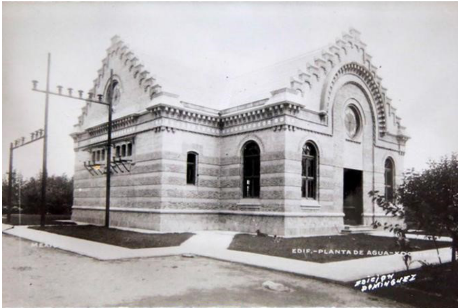
Fig. 2. Vista de la "Planta de agua" de Nativitas, en Xochimilco, postal ca. 1920. Se observa el tendido eléctrico y su importancia para el funcionamiento de la maquinaria. Fuente: Edición Domínguez. Colección de los autores.
