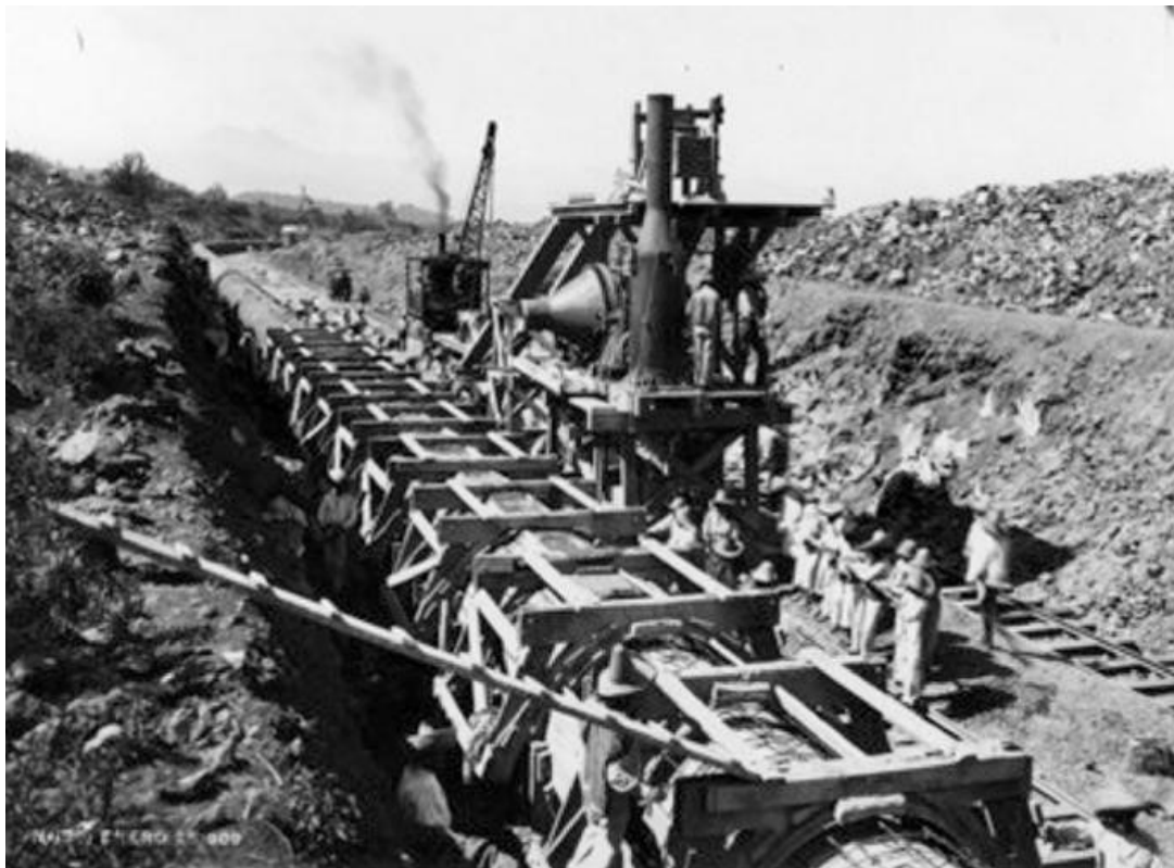
Fig. 5. Personas trabajan en la construcción de una tubería de agua, 1909. Se muestra la innovación técnica y tecnológica del uso del concreto. Fuente: Fotografía no identificado (1909-01-25). Dirección del Sistema Nacional de Fototecas. Mediateca. INAH. Catálogo. 653225.
