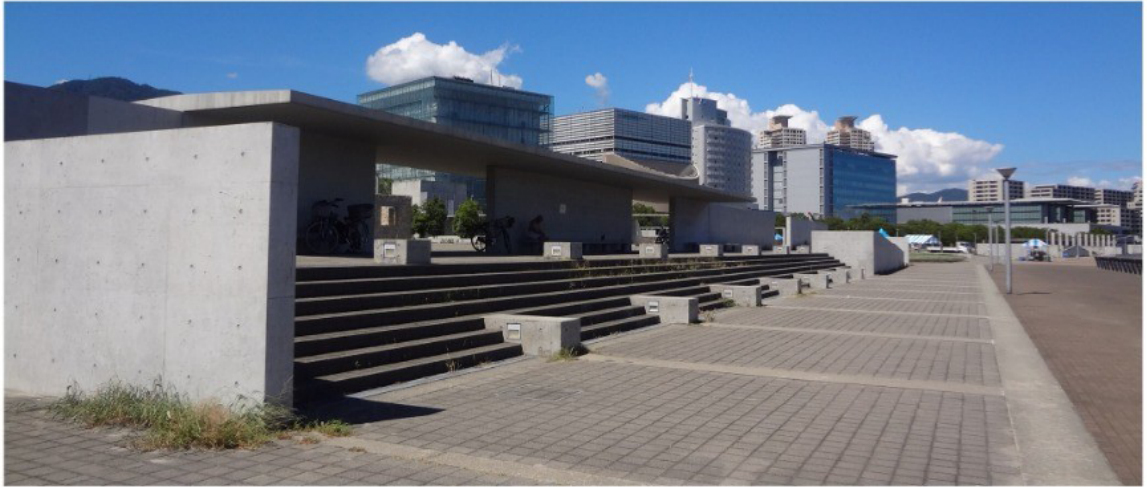
Figura 16. Espacio abierto que se modela con algunos muros espaciados dando seguridad e intimidad a un lugar que se habitará en momento de emergencia. Fuente propia.
