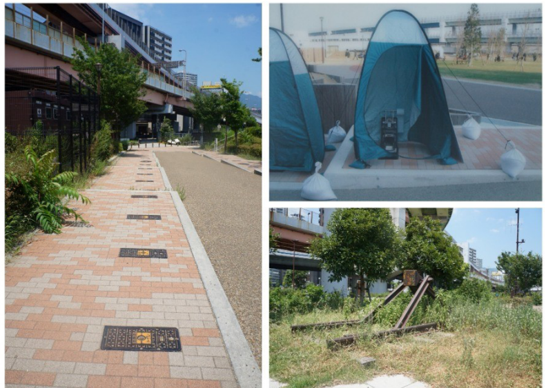
Figura 20. Infraestructura sanitaria organizada de forma lineal para habilitarse en caso de emergencia. Fuente propia. Figura 21. Cubiertas tipo campaña que se colocan sobre los registros sanitarios para atender a la población en caso de emergencia. Fuente propia. Figura 22. Elementos escultóricos con los restos de las antiguas vías del tren que funcionan como elemento de memoria del lugar. Fuente propia.
