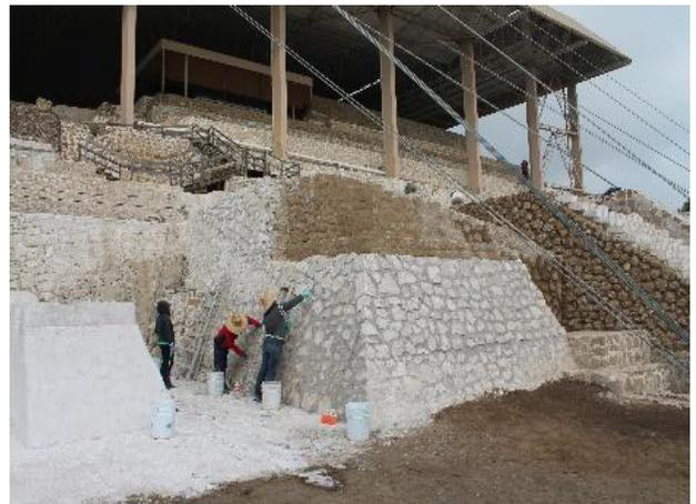
Figura 7. Proceso de reconstrucción masiva de la pirámide de Cacaxtla, Tlaxcala, México. (Foto: L. Guerrero, 2014).
