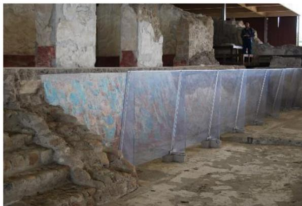
Figura 5. Pinturas murales realizadas con cal sobre sustratos de bloques de “tepetate”. Cacaxtla, Tlaxcala, México. (Foto: L. Guerrero, 2009).
