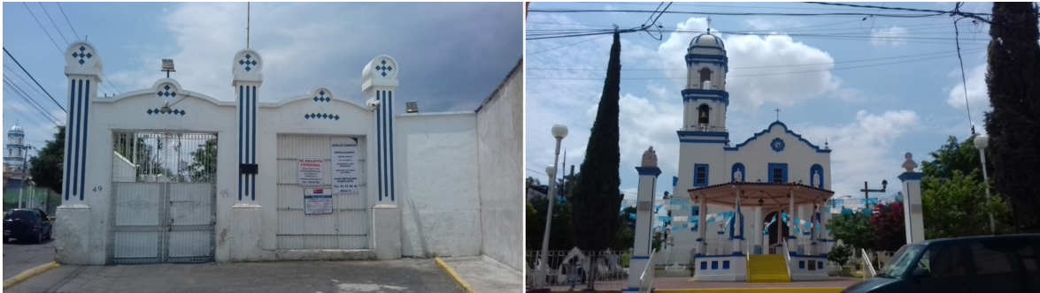
Figura 6. De izquierda a derecha. Vestigios de la entrada a la fábrica de La Experiencia y el templo de Nuestra Señora de El Refugio, parte del patrimonio industrial de la zona. Fuente: Archivo propio.
