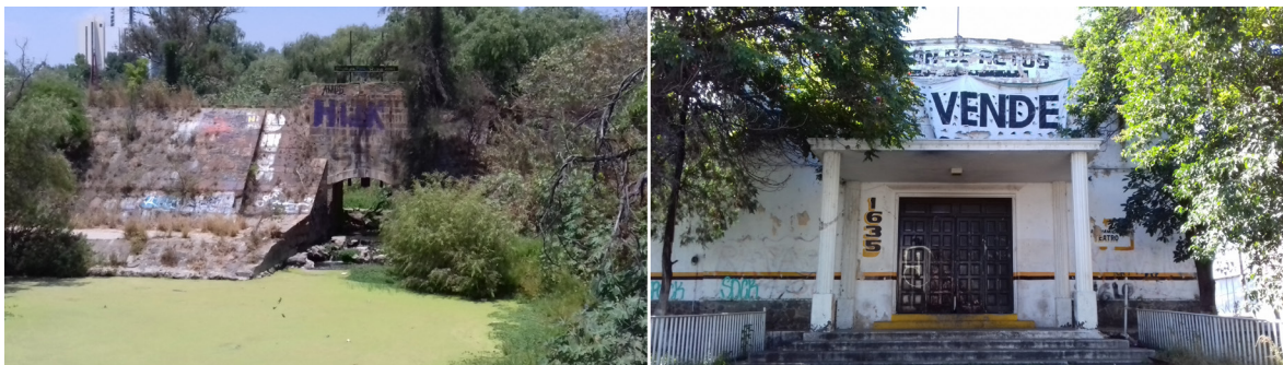
Figura 9. De izquierda a derecha, fotografías del 2017. La presa de Zoquipan, catalogada ante el INAH, antes de la intervención del gobierno de Jalisco para convertir a la antigua presa en un vaso regulador; y el teatro Jesús Macías, aún de pie, antes de su venta. Fuente: Archivo propio.
