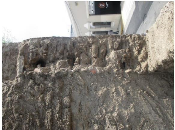
Figuras 16 y 17. Vista de las alturas de los muros de adobe exteriores, de 4.72 m; con un ancho de 0.60 m. Tamaño del adobe de 0.53 largo, x 0.28 de ancho x 0.10 m espesor. Fuente: Jiménez (2006-2007).
