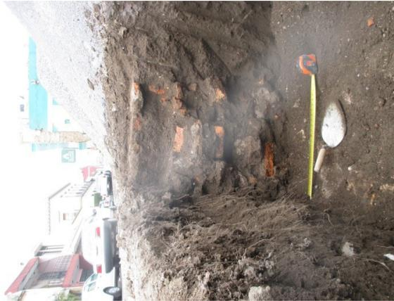
Figura 13. En esta imagen se aprecia el desplante de los muros de adobe sobre un cimientado de ladrillo 0.92 de altura, de profundidad -0.62 a -1.54 m, con un ancho de 0.62 m; los tamaños de los ladrillos son 0.46 x 0.29 x 0.5 m, y 25 x 15 x 0.7 m. Fuente: Jiménez (2006-2007).
