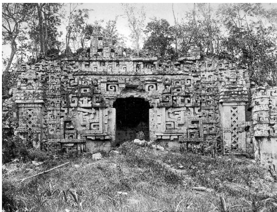
Figura 10. Fotografía de la Estructura II de Hochob a finales del siglo XIX tomada por Teobert Maler (1895).
