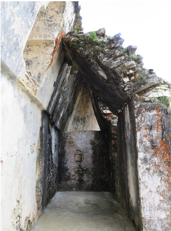
Figura 13. Vuelco como sólido rígido de una parte de la bóveda en la Casa D del Palacio de Palenque. Laura Gilabert, 2015.
