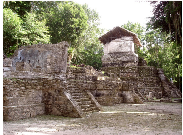
Figura 9. Plaza principal de Topoxté, con los edificios C, D y G. Estado actual de los edificios, cuya restauración terminó en 1996. Raúl Noriega Girón, 2019.
