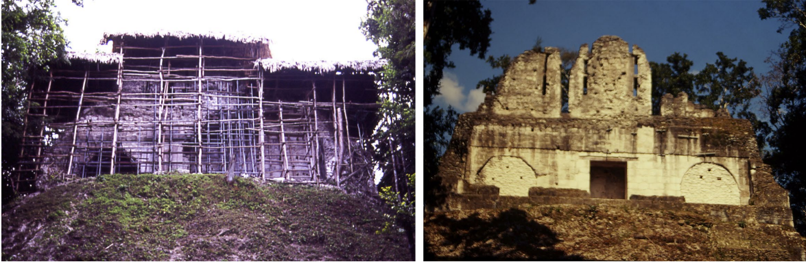
Figura 6. Edificio A de Nakum: (izq.) Fachada oeste, donde se muestran los apuntalamientos y una cubierta protectora temporal previa a los trabajos de restauración. Raúl Noriega Girón, 1990. (der.) Estado actual del edificio. Raúl Noriega Girón, 2019.
