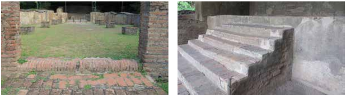
Figura 5. Izquierda: Detalle de ladrillos en la entrada. Derecha: gradas al altar en la Iglesia La Merced de León. Créditos: la autora.
