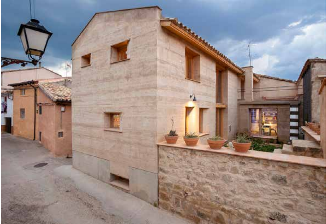
Figura 2. Imagen de la fachada del edificio estudiado. (Fuente: la autora).
