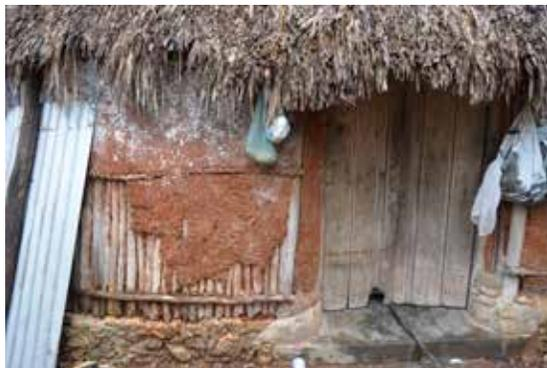
Figura 3. Detalle del muro de bajareque en el que se aprecia la estructura de madera (kololche) amarrada con bejuco y recubierta con el embarro (pak'lu'um). Nunkiní, Campeche. Fuente: Tomada por el autor, 2015.
