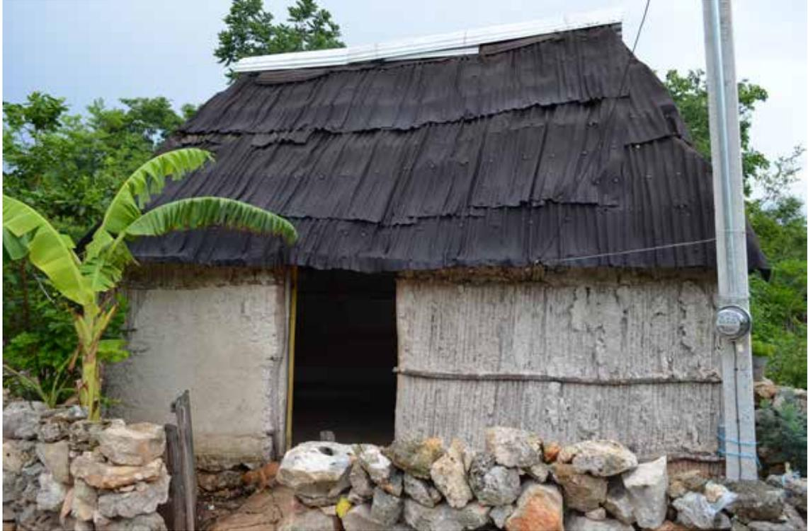
Figura 5. Vivienda con muros de bajareque con sajkab, la única identificada de un total de 502 casas registradas en Nunikiní, Campeche. Fuente Tomada por el autor, 2015.
