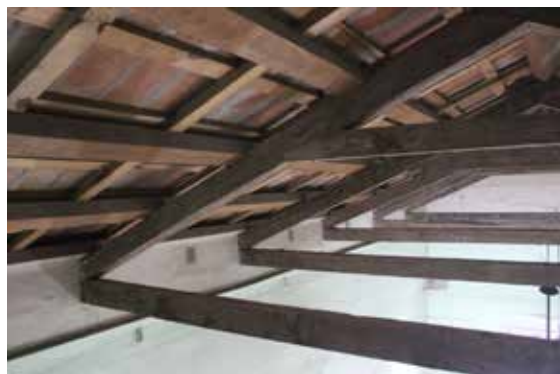
Figura 11. Detalle de la estructura del techo del Cabildo. Fotografía: autores.
