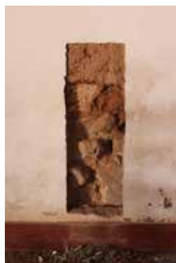
Figura 6. Cateo en la Iglesia de Uquía donde se observa el sobrecimiento. Fotografía: autores.
