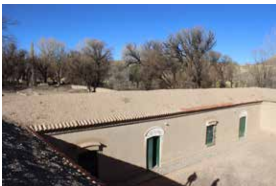
Figura 15. Vista del torteado en la Casa del Marqués. Fotografía: autores.
