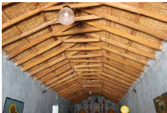
Figura 12. Vista de las tijeras de madera de Cardón en la Iglesia de Tabladitas. Fotografía: autores.
