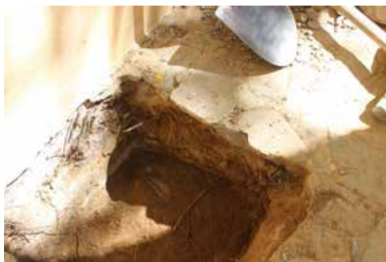
Figura 7. Vista de los cimientos en la Casa del Marques. Fotografía: autores.
