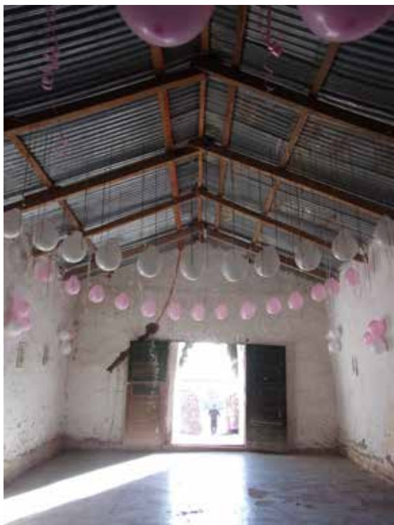
Figura 6. Interior de la nave con vista hacia la puerta principal. Se observa la estructura de madera de la cubierta y la ornamentación del día de la fiesta. Foto de la autora.
