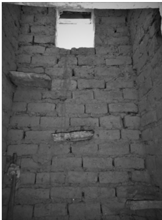
Figura 7. Muro interior de torre campanario. Se observan las piedras empotradas, por donde se asciende para realizar el repique. Foto de la autora.
