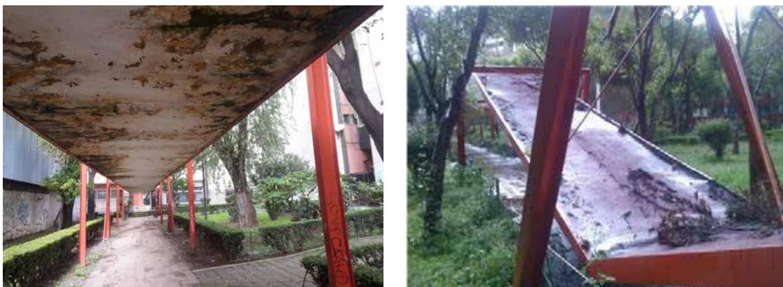
Figura 4. Fuente: [Fotografía Izquierda de Michelle Reza Flores]. (Pasos a cubierto dañados por filtraciones, recorrido de campo), 2017. Fotografía de la derecha. extraída de "Vivir en Tlatelolco" periodismo comunitario. Recuperada en: <http://vivirtlatelolco.blogspot.com>
