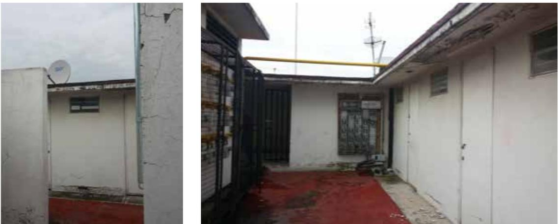
Figura 13. Cuartos de azotea del Edificio Presidente Juárez, Segunda Sección; desprendimiento de aplanados, encharcamientos, filtraciones; acceso controlado, uso que les destinan como área de almacenamiento. FUENTE. [Fotografías de Michelle Reza Flores]
