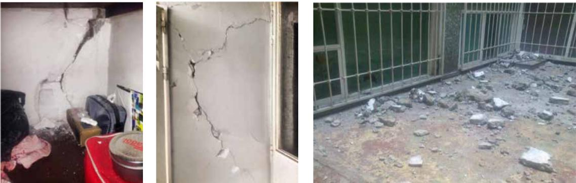
Figura 14. Daños ocasionados por el sismo mayo 2014; interiores de vivienda; planta baja en Edificio tipo "A". FUENTE. [Fotografías de Michelle Reza Flores]
